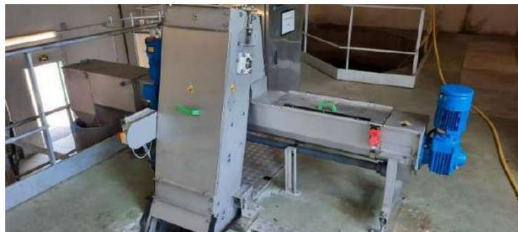
Dégrilleur fin 6 mm et compacteur à déchets en remplacement de l'ancien dégrilleur 20 mm
